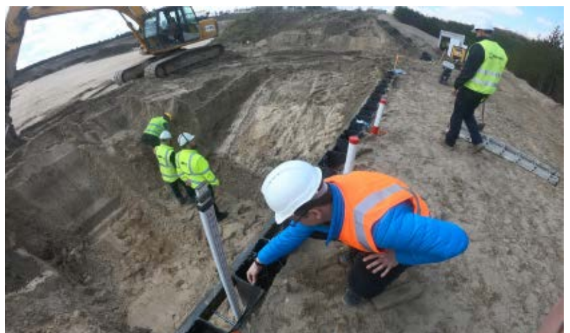
Weryfikacja połączeń światłowodowych do czujników foto: arch. autora
